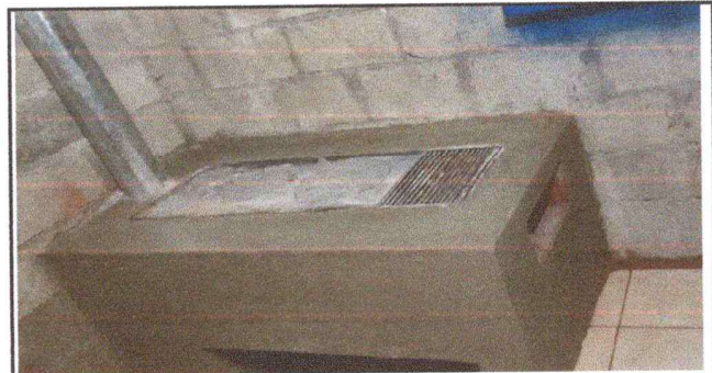
Foto 4: polleton en mal estado.
